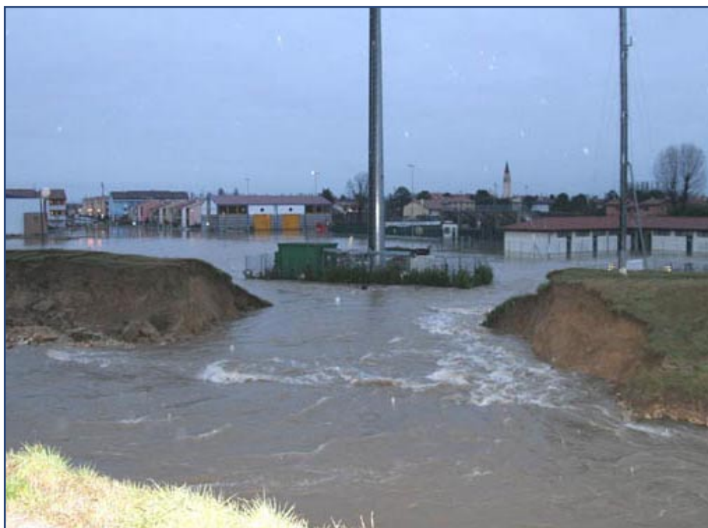
La rottura dell'argine del Muson dei Sassi, a Loreggia
